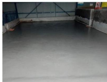
水泥防腐层施工
