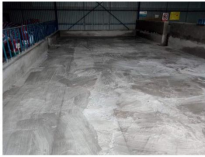
地面水泥基础施工
